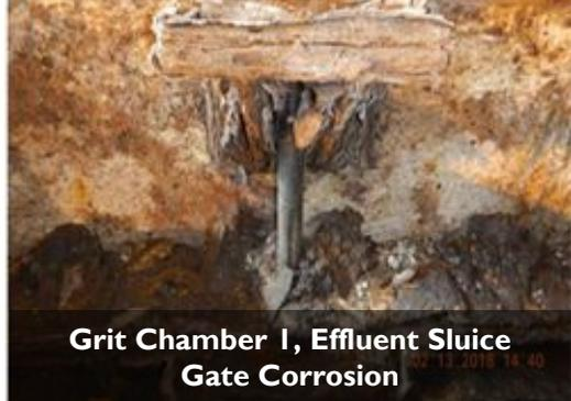
**Grit Chamber I, Effluent Sluice Gate Corrosion**
