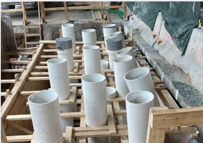
CSO 024: Jet Grout Sleeves
