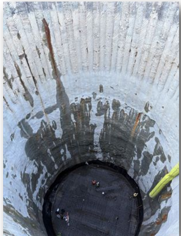
CSO 022: Reinforcing Shaft Base Slab
