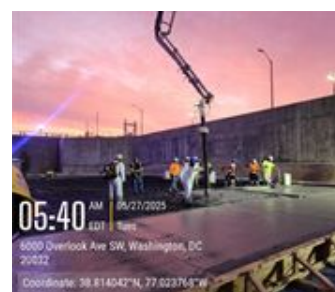
Concrete Slab Section Pour
