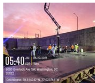
Concrete Slab Section Pour
