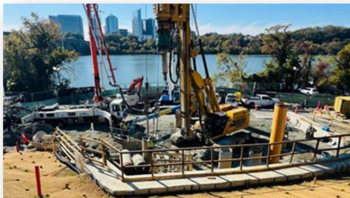
CSO 028: Secant Pile Construction
