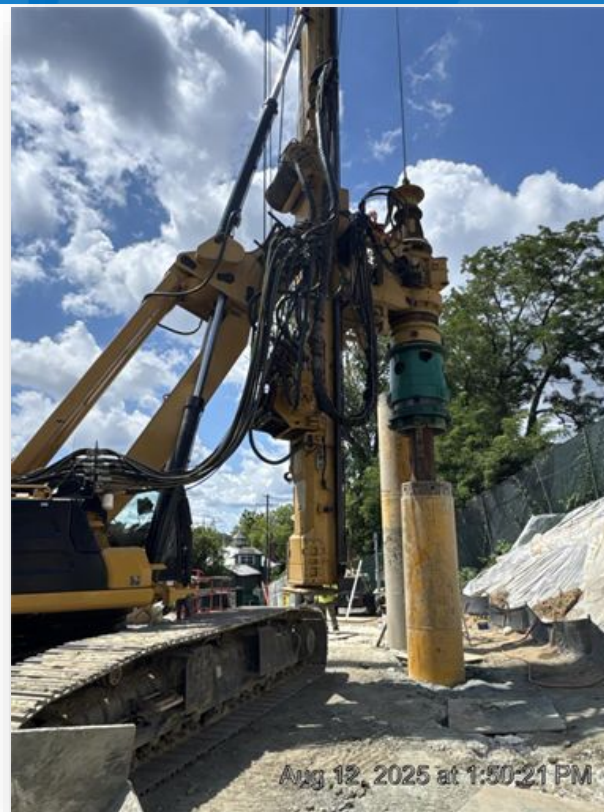
CSO 028 Ventilation Vault Secant Piles
