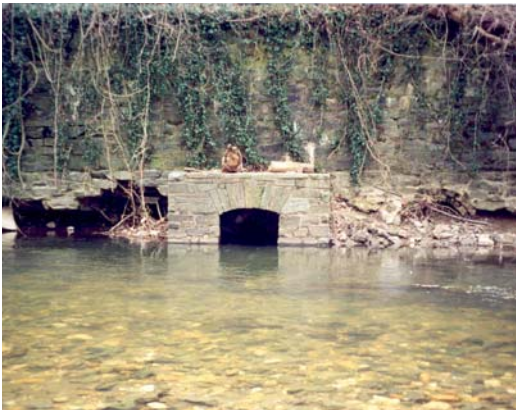
Example CSO Outfall – CSO 040 to Rock Creek
